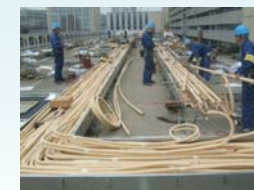
(参考)工事の状況
