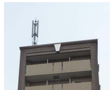
アンテナ設置
