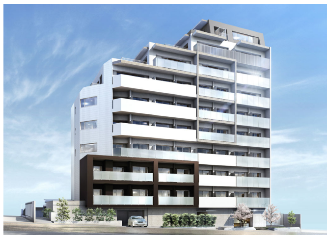
(仮称)プライムアーバン目黒大橋ヒルズ
