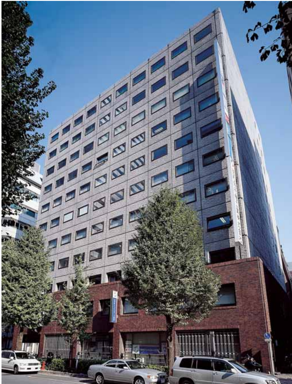
西新宿昭和ビル外観写真
