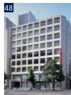
48 NRE Hiroshima Bldg. 野村不動産広島ビル
