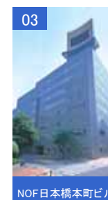
NOF日本橋本町ビル
