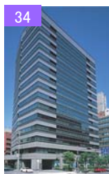
34 野村不動産四ツ橋ビル
