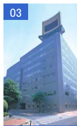
03 NOF日本橋本町ビル
