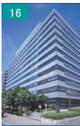
16 NOFテクノポート カマタセンタービル
