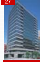
野村不動産四ツ橋ビル
