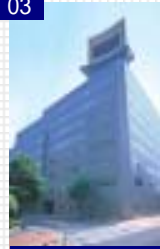
NOF日本橋本町ビル
