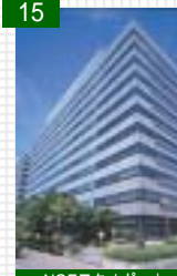
NOFテクノポート カマタセンタービル
