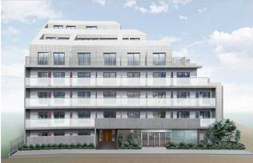
(4)(仮称)ジェイフラッツ武蔵小山
