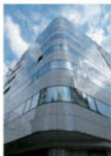
B-14 Route Ikebukuro Building ルート池袋ビル
