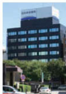
E-7 Tokyuseimei Nipponkai Tenjima Building 東京生命・日本興業富山ビル
