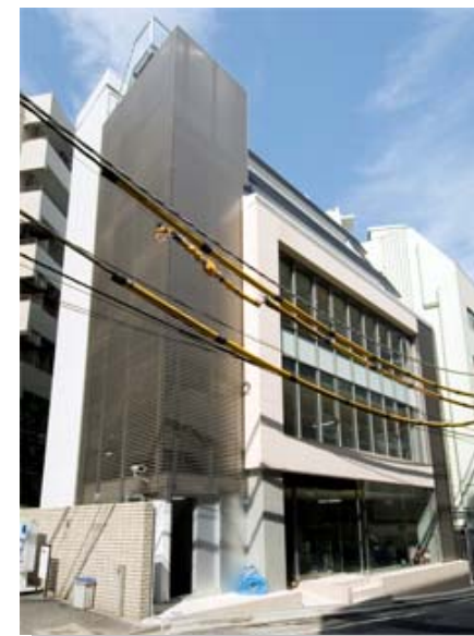
A-27 COI赤坂溜池ビル
